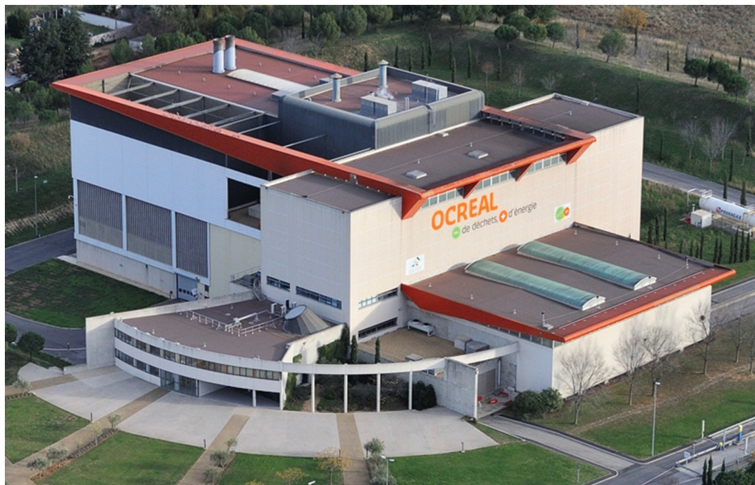
Unité de valorisation énergétique OCREAL
