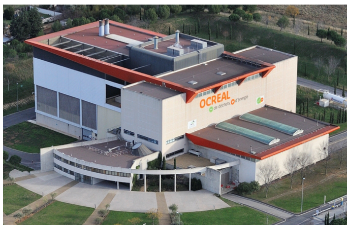
Unité de valorisation énergétique OCREAL
