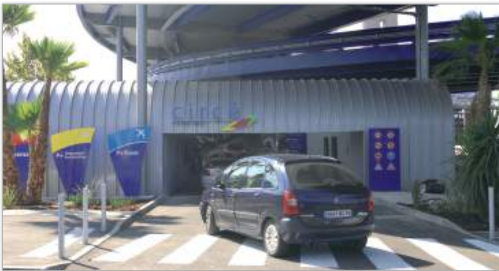
◀ Odysseum, pôle d'échanges d'agglomération (parking Circé en ouvrage)
