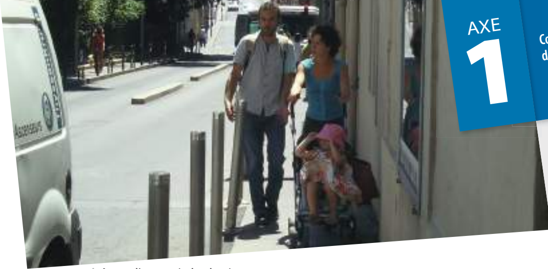
↑ Assurer l'ergonomie des cheminements Dans l'exemple ci-dessus, la faible largeur du trottoir et l'encombrement supplémentaire généré par les potelets rend le déplacement de deux personnes côte à côte inconfortable.
