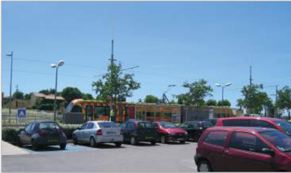
◀ Saint Jean de Védas Centre, pôle d'échanges de proximité
