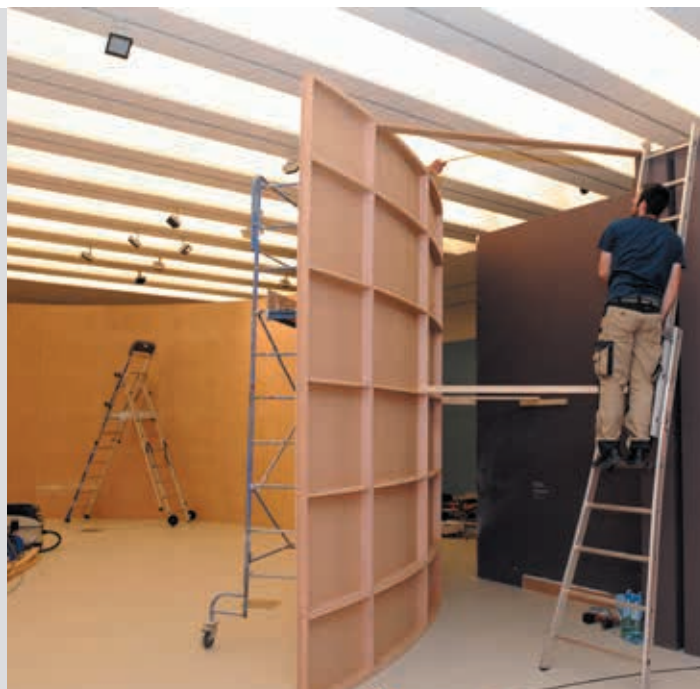
4 semaines de montage ont été nécessaires à la réalisation de la muséographie conçue par Martin Michel. Suivront deux jours de grand nettoyage et deux jours de séchage avant de retrouver les conditions climatiques adaptées à l'accueil des œuvres.
