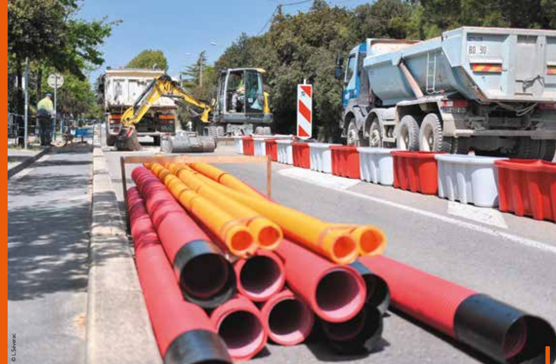
Le chantier de la ligne 5 est lancé route de Mende avec le dévoiement des réseaux.
