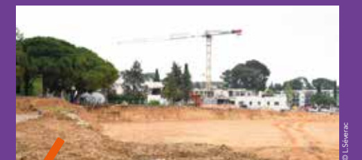
Le chantier de l'Atrium Learning Center, nouveau concept de bibliothèque inter-universitaire.
