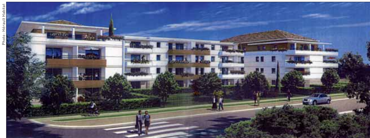
Photo : Hérault Habitat Résidence de la Zac de Maumarin au Crès construite par Hérault Habitat
