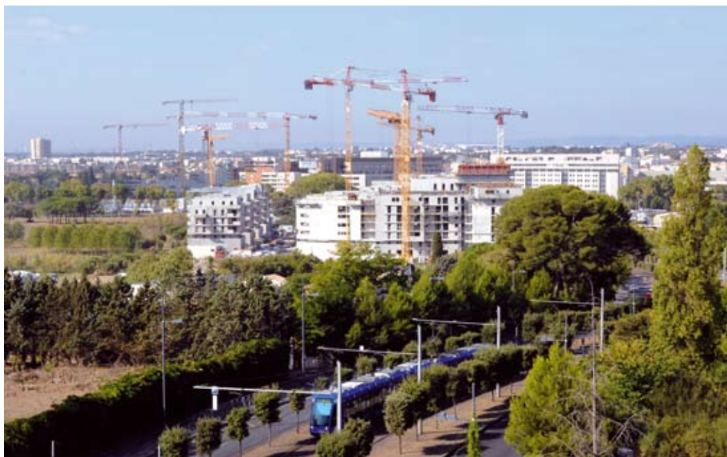
Les grues dans le ciel de l'Agglo ont encore de beaux jours : l'Agglomération construira 5 000 logements par an jusqu'en 2012, dont 1 600 logements sociaux.
