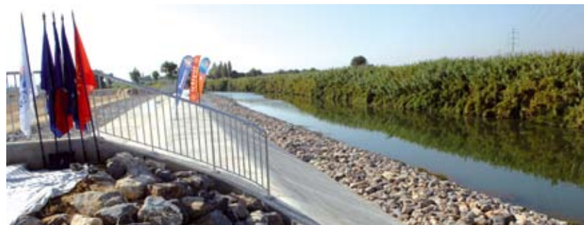
Après la construction du Chenal de la Lironde qui permet de délester une partie des crues du Lez, Montpellier Agglomération débute en 2009 le confortement des digues du fleuve.
