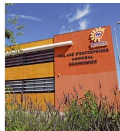
Le Village d'Entreprises Artisanales et de Services (VEAS) Hannibal de Cournonsec est occupé à 100%.
