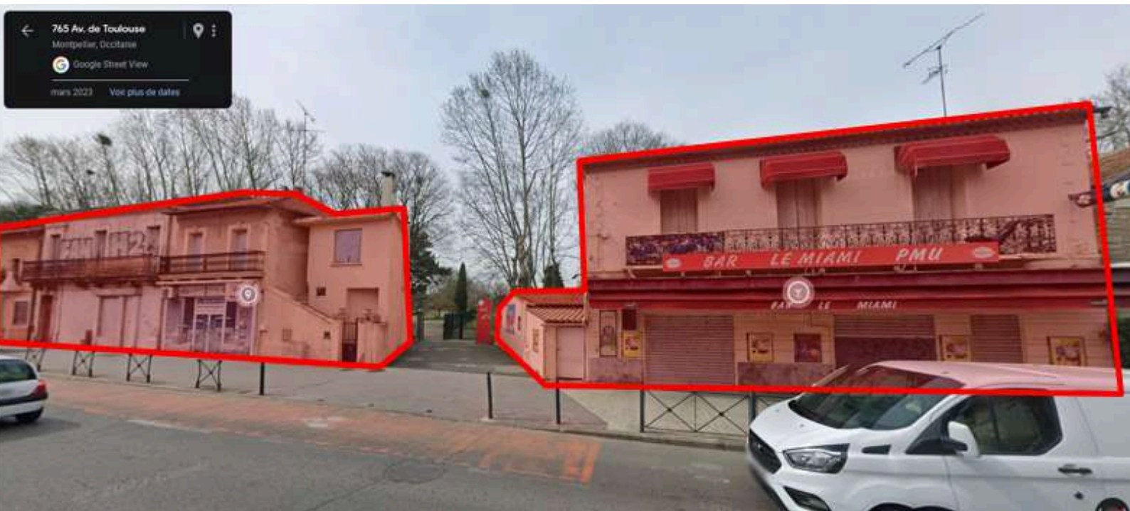
Bâtiments démolis en janvier 2025 : avenue de Toulouse
