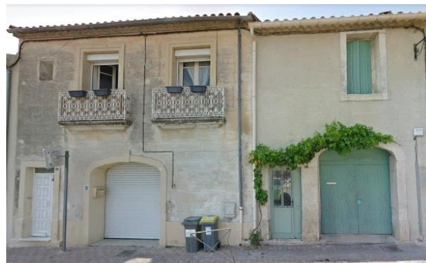
Portes charretières, balcons et baies à préserver. Bon traitement des menuiseries à droite. Contre-exemple à gauche
