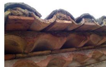
Le surplomb est porté par des chevrons, une corniche ou une génoise. Ici une génoise à deux rangs.
