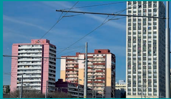
LA TOUR D'ASSAS Démolition en 2024.
