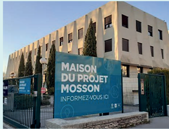
L'ESPACE GISÈLE HALIMI (ANCIENNEMENT URSSAF) Un nouvel équipement public autour des solidarités qui accueille la Maison du Projet Mosson.
