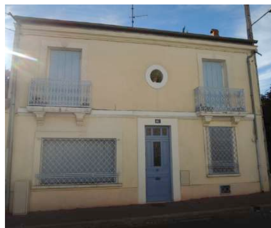
Il est souhaitable d'utiliser les dispositions existantes, ou de les retrouver, par exemple avec des grilles de ventilation harmonisées à la façade.
