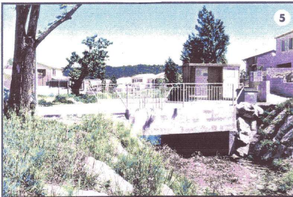
Ouvrage limitant dans le lotissement - Transformateur vulnérable
