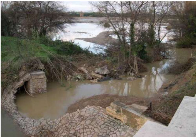
Dégâts sur une digue (Mosson - 12/2003 - photo DDTM)
