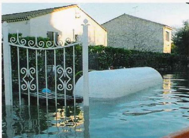
Cuve soulevée par l'eau.
