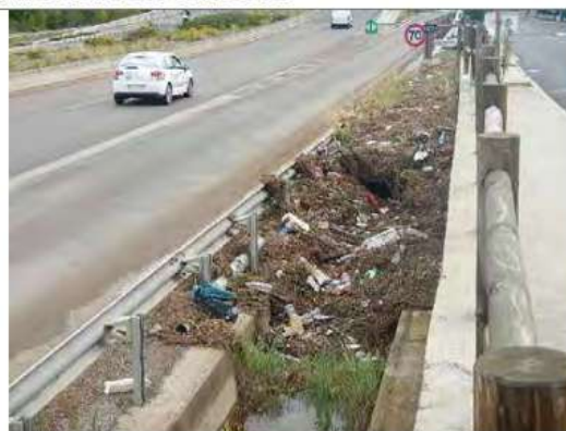
Embâcles sur ouvrage d'évacuation RD66
