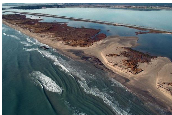
Illustration 55 : Photographie aérienne de janvier 1998, après la tempête de décembre 1997. Sur cette photo, les écluses se trouvent clairement en mer (DREAL Occitanie).
