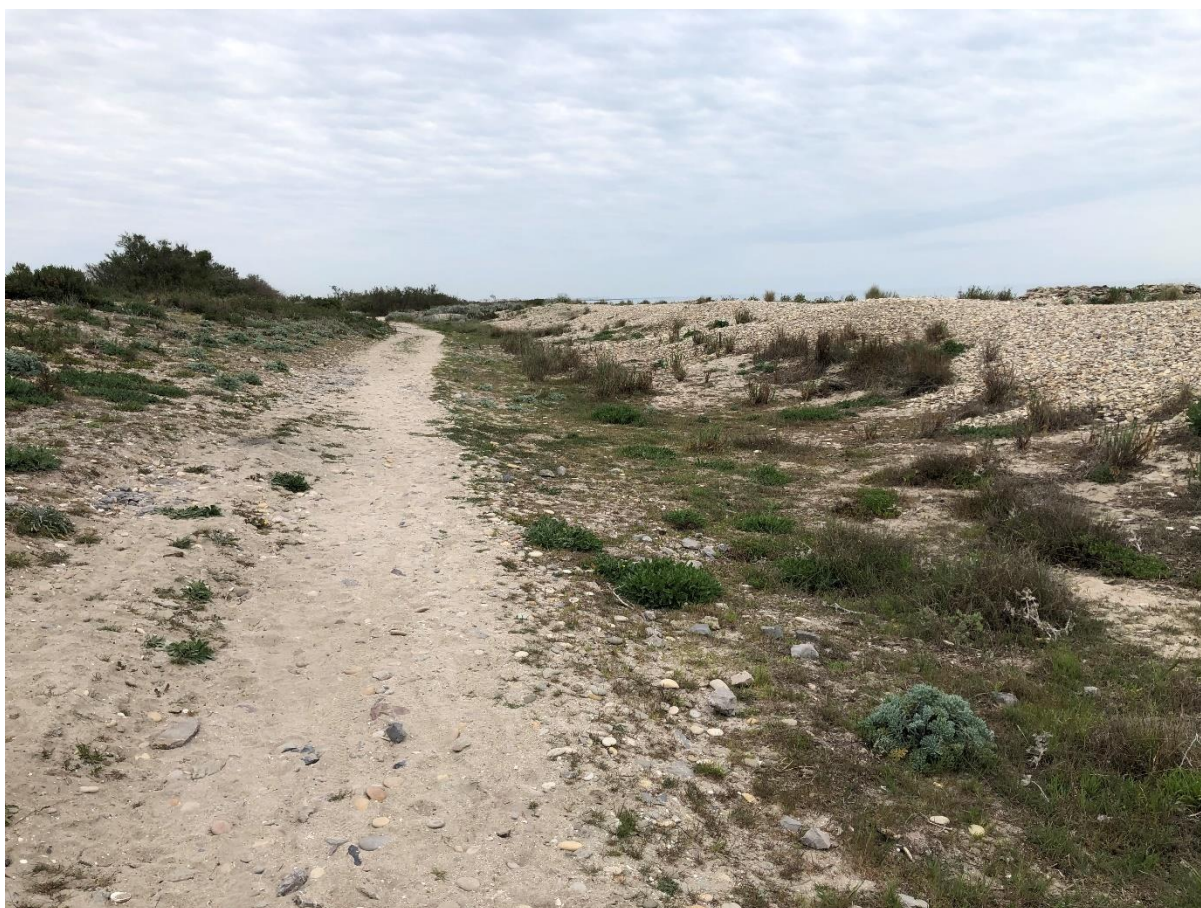
Illustration 35 : Exemple d'un ouvrage dégradé de la fin des années 1980 (à gauche), et de lobes de dépôts de galets marins (à droite), sur le lido de Maguelone (SaVE, avril 2023).
