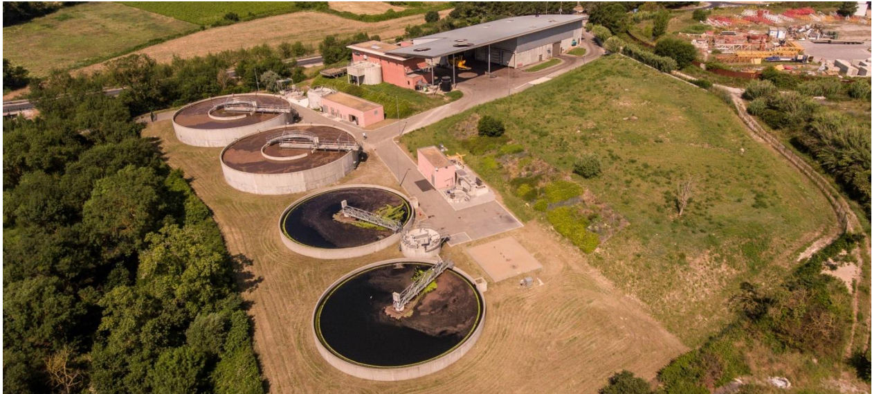
Figure 73 : Station d'épuration de Fabrègues
