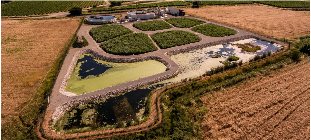
Figure 45 : Station d'épuration de Sussargues et Saint Geniès des Mourgues
