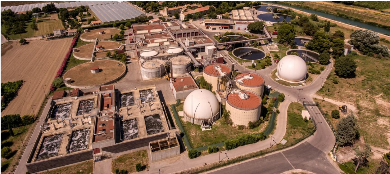
Figure 88 : Station d'épuration de MAERA
