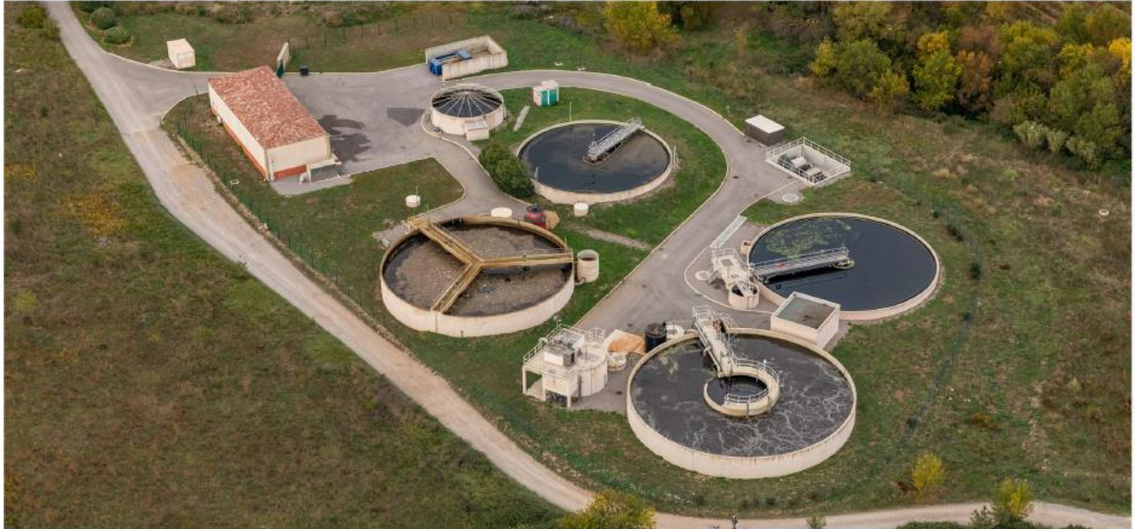
Figure 26 : Station d'épuration de Cournonsec Cournonterral
