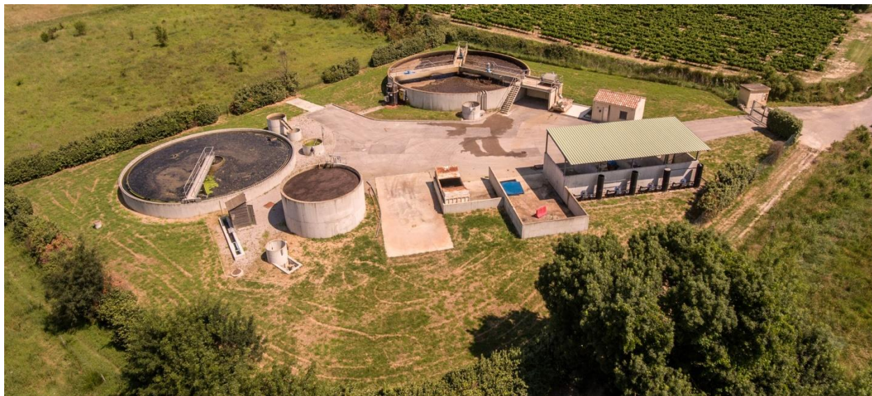
Figure 38 : Station d'épuration de Lavérune
