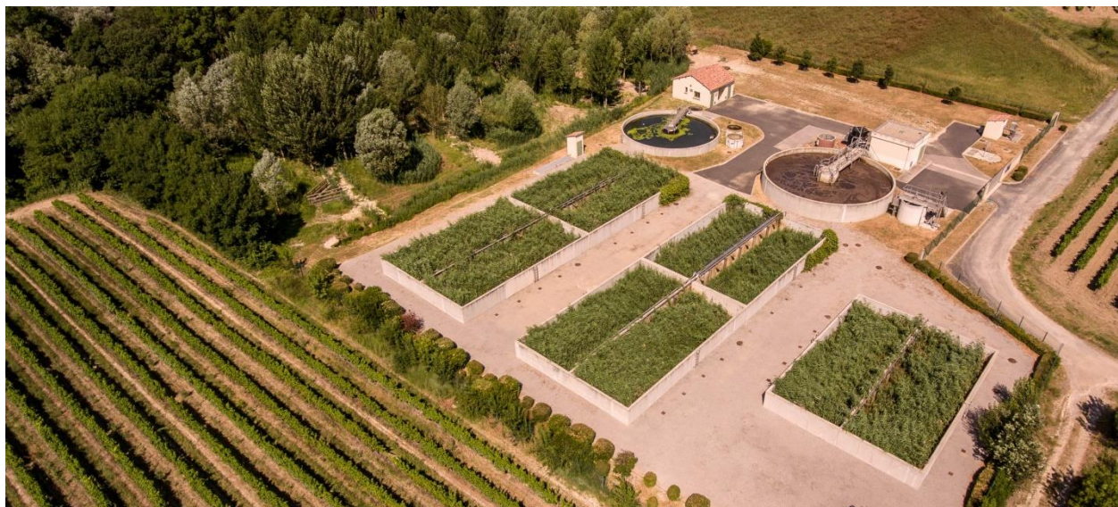
Figure 5 : Station d'épuration de Saint Drézéry
