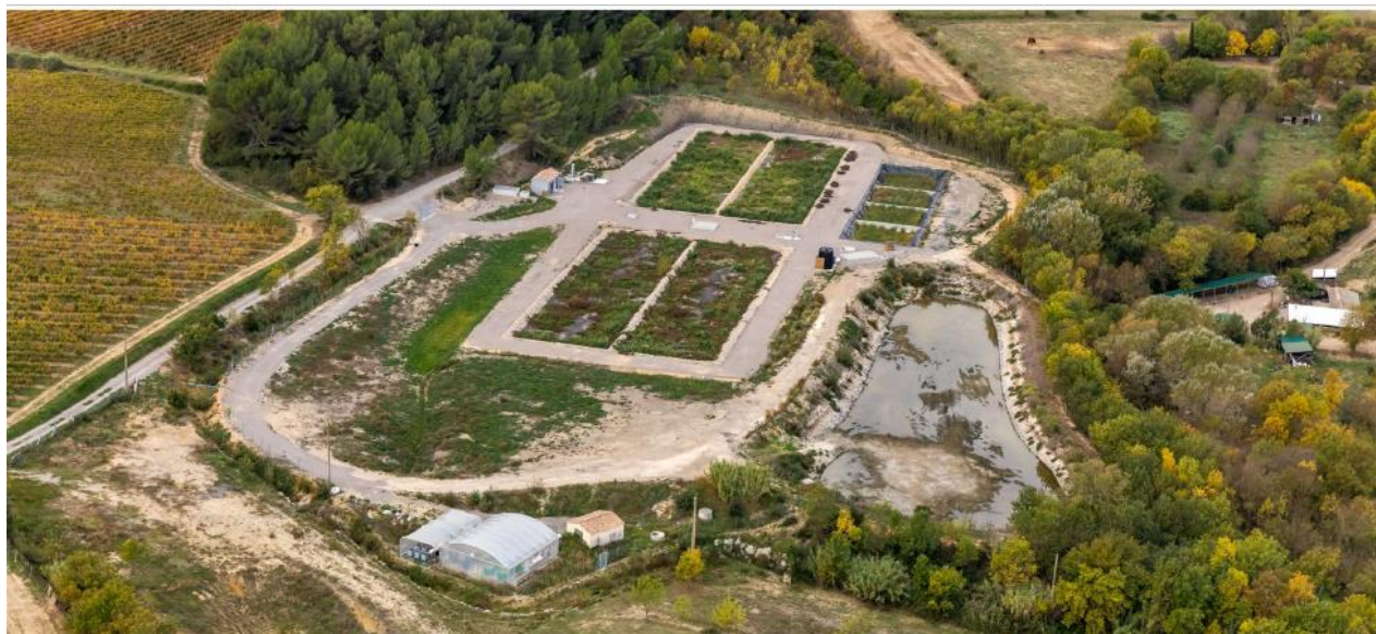
Figure 52 : Station d'épuration de Murviel Lès Montpellier
