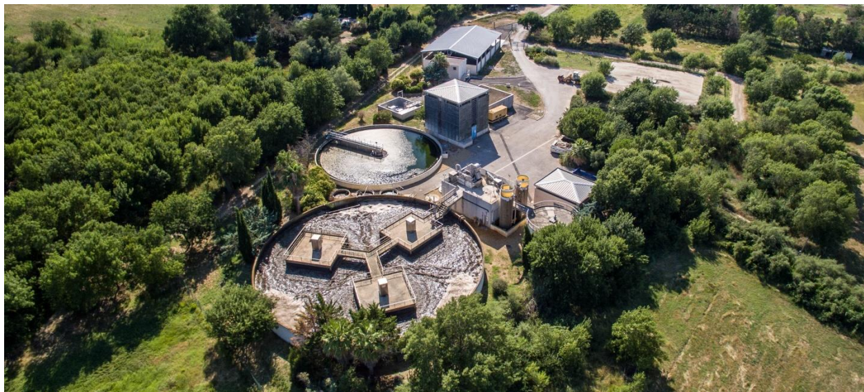
Figure 59 : Station d'épuration de Villeneuve Les Maguelone
