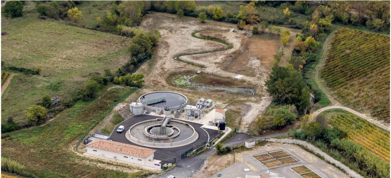
Figure 80 : Station d'épuration de Saint Georges d'Orques
