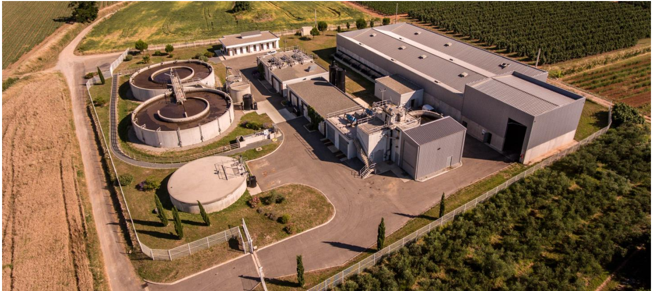
Figure 12 : Station d'épuration de Baillargues-Saint Brès
