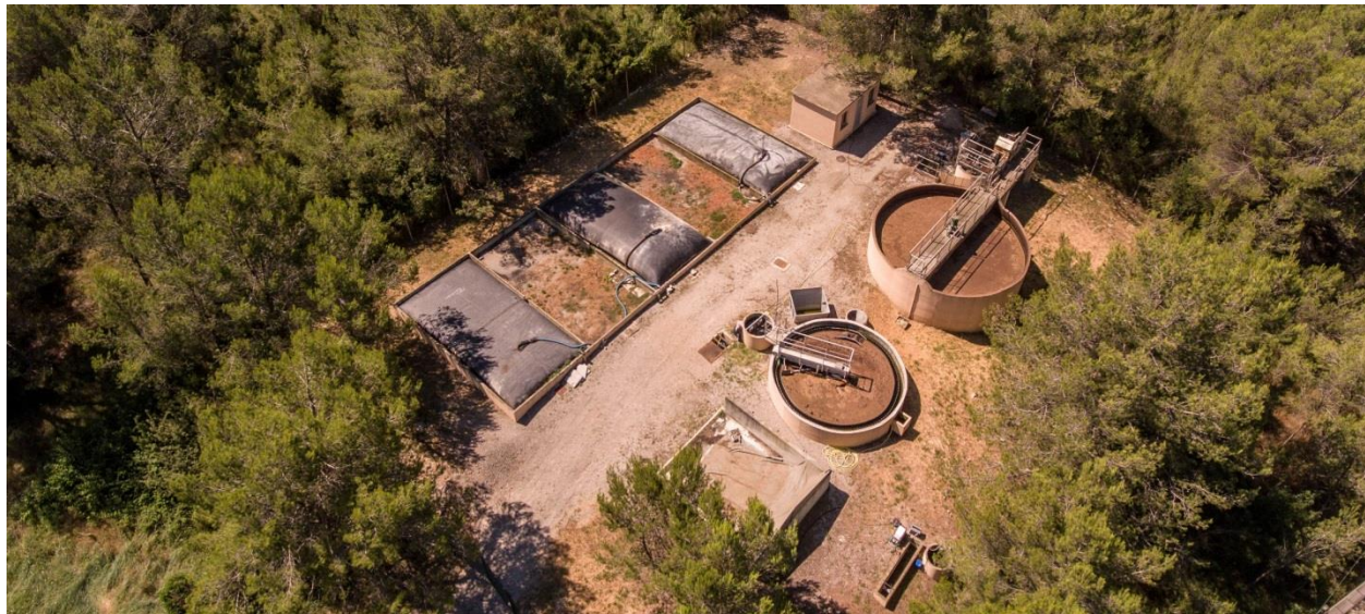
Figure 66 : Station d'épuration de Montaud
