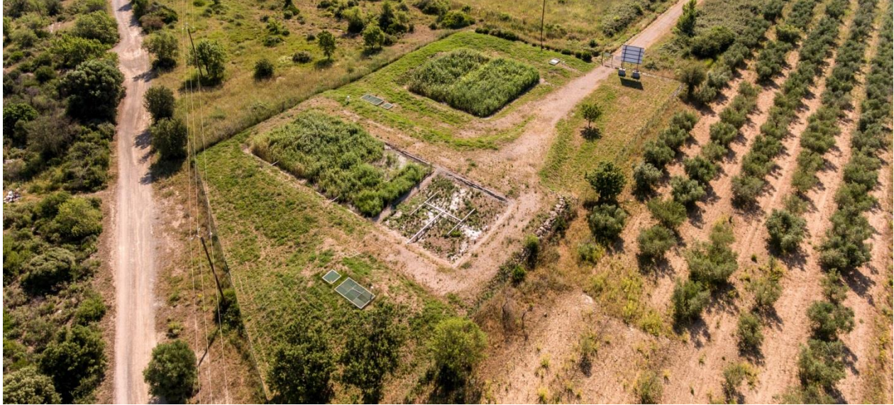
Figure 32 : Station d'épuration de Cournonsec Mas Plagnol
